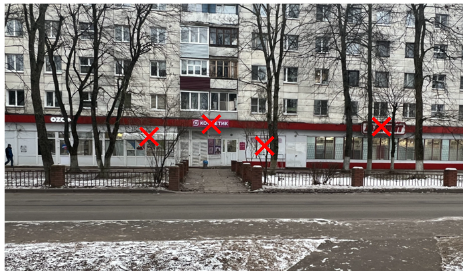
Вывески на подложке Сплошная заклейка окон Фрагментарная отделка цоколя Навес над окнами
