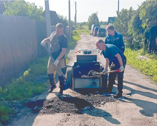
Точечный ремонт выбоин в п.Молодцово
