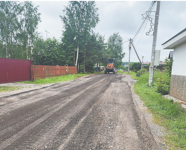
Подсыпка и грейдирование в микрорайоне Марьино
