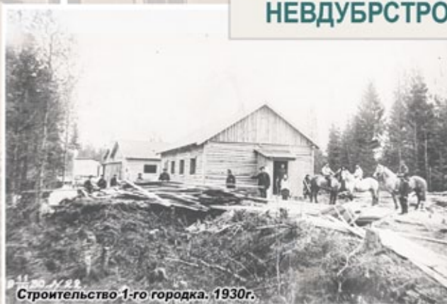
Строительство 1-го городка. 1930г.
