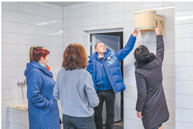
Приемка ремонтных работ в мужском отделении кировской бани 29.12.2022
