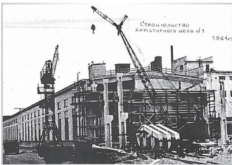
Строительство арматурного цеха №1, 1964 г.
